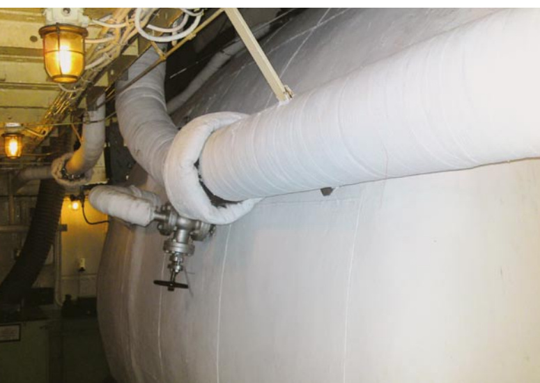
In het ruim van de Elevator gaat Jorrick Tv een beeldprojectie realiseren waardoor het lijkt alsof er stoom door de buizen loopt.
